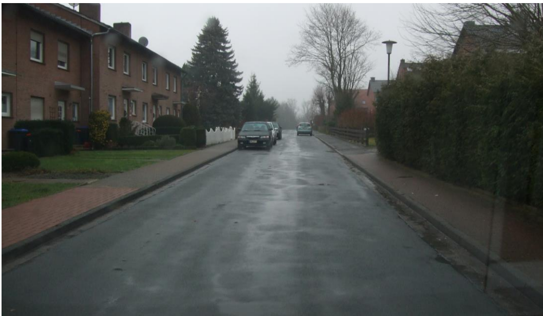
Bergstraße, Abschnitt Narzissenstraße - Albert-Schweitzer-Straße
