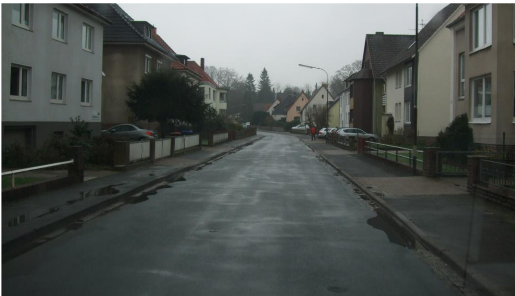
Bergstraße, Abschnitt Schilfstraße - Henningstraße
