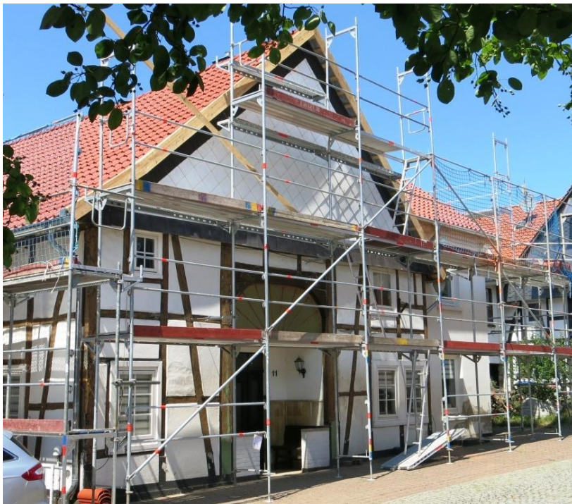
Die ersten privaten Maßnahmen der Verbunddorferneuerung Weserdörfer werden umgesetzt Foto: Planungsbüro Flaspöhler
